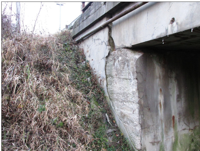
Opadávající omítka opěr, zvodnělá spára mezi NK a závěrnou zídou - zde pravé křídlo OP1.
