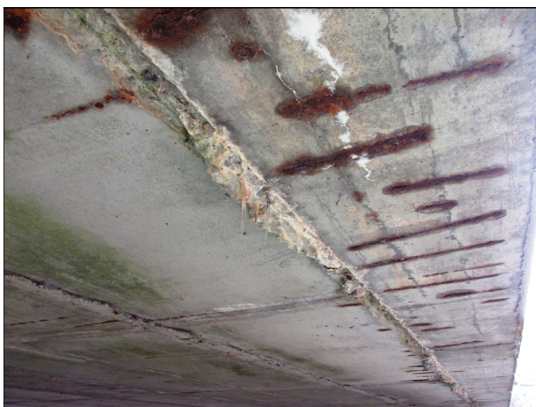
Výluhy s inkrustacemi ve spárách mezi krajními nosníky a na podhledu nosníků vpravo, odhalená korodující výztuž.
