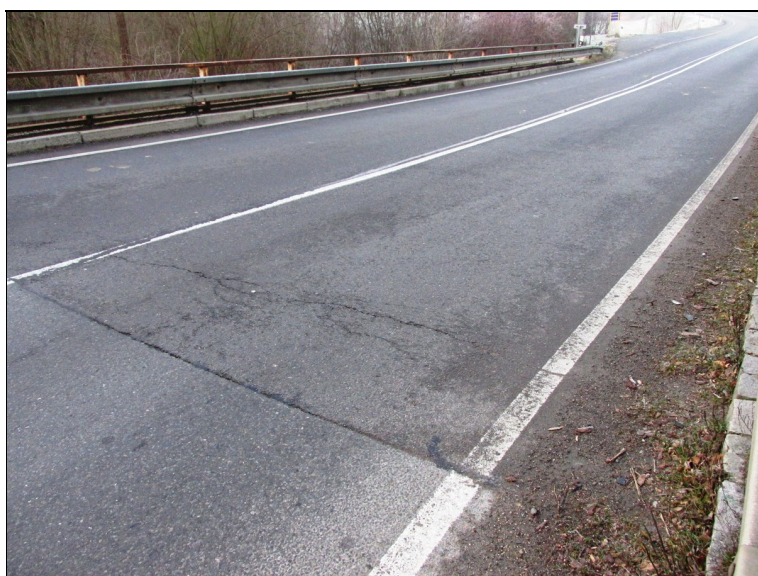
Příčné trhliny ve vozovce za opěrou OP2 vlevo, nečistoty na krajnici.
