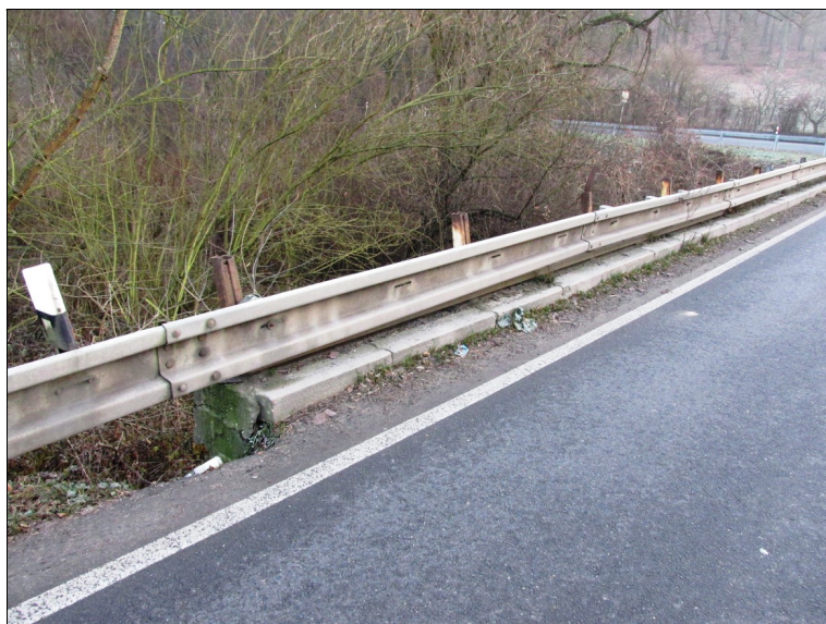
Nátrž krajnice vozovky před levou římsou.
