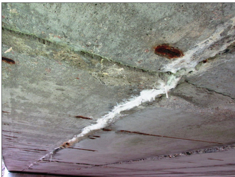
Výluhy s inkrustacemi ve spárách mezi krajními nosníky vlevo.
