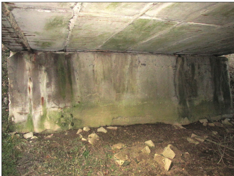
Pohled na opěru OP1 - silné průsaky, degradace betonu při patě OP; rozplavené opevnění.
