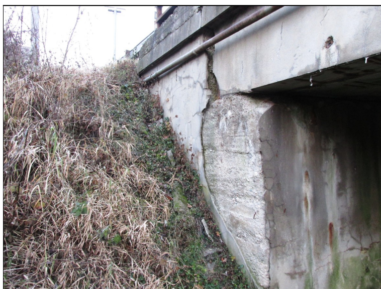
Opadávající omítka opěr, zvodnělá spára mezi NK a závěrnou zídou - zde pravé křídlo OP1.
