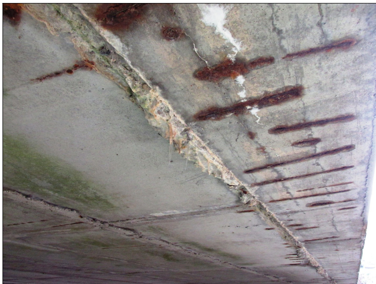
Výluhy s inkrustacemi ve spárách mezi krajními nosníky a na podhledu nosníků vpravo, odhalená korodující výztuž.
