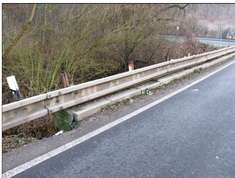
Nátrž krajnice vozovky před levou římsou.
